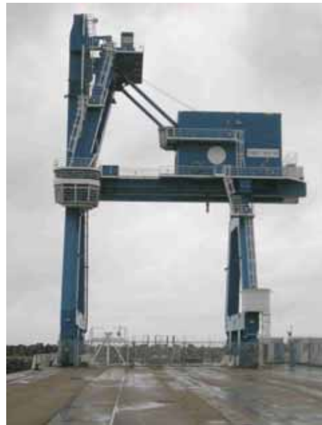
フラマン埠頭にある原子力関連輸送物用のガントリークレーン
