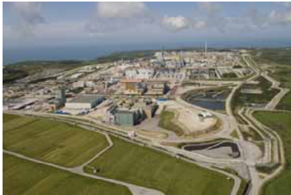
ラ・アーク再処理工場全景
