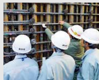
▲平成23年第1回点検の様子(防波壁基礎部)
