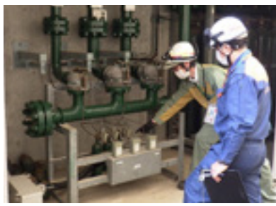
▲浜岡原子力発電所内の二酸化炭素消火設備を調査している様子
