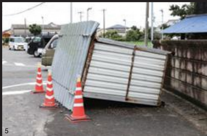
1.ビニールハウスが直撃した住宅/2.突風により吹き飛ばされて原形をとどめていないソーラーパネル/3.24日にがれきなどの撤去作業をした市役所職員/4.吹き飛ばされたトラックのコンテナを回収する業者/5.突風により約10 m 移動し倒れたごみ集積所
