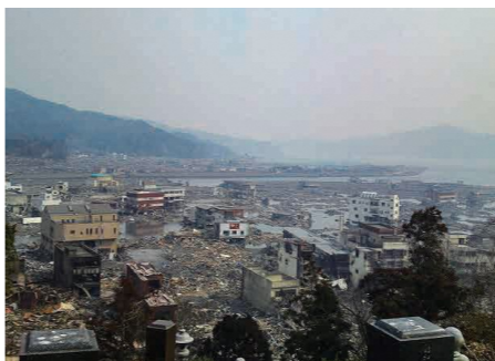
城山から見た震災時の大槌町(岩手県建設業組合提供)
