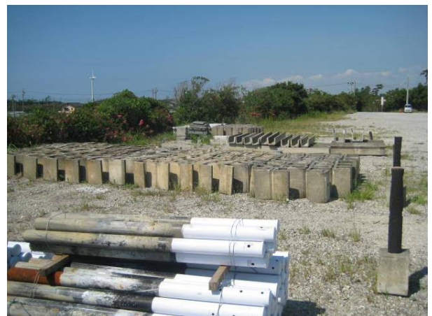
再使用のための土木資材ストック
