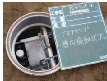
槽内稼働状況
