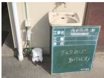
ブローア設置状況
