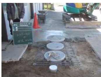
スラブ (コンクリート打ち)
