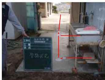
管路埋設状況
