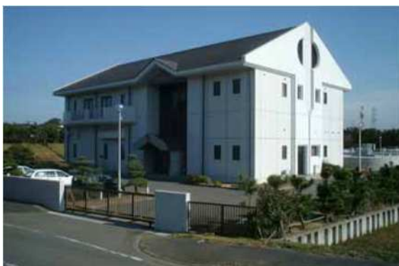
池新田浄化センター
