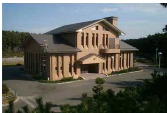
高松浄化センター
