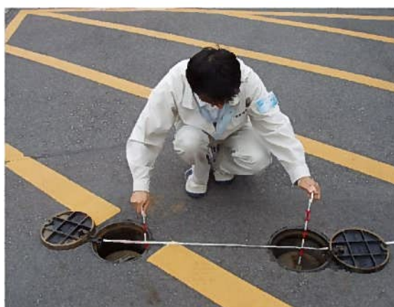
(左側 公共ます) (右側 宅内ます)
