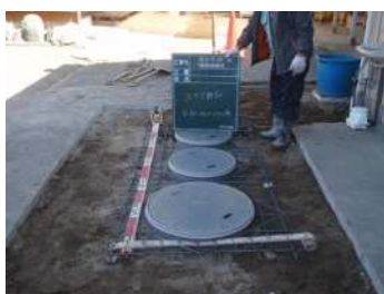
スラブ（鉄筋） 設備土
