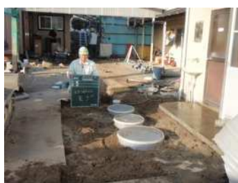
埋戻し完了 設備土
