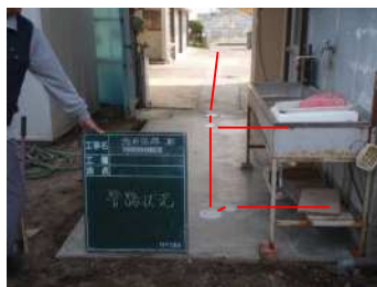
管路埋設状況
