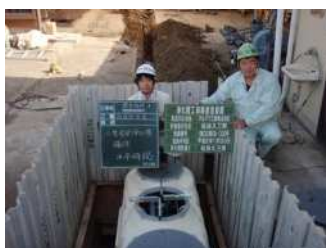
据付、水平確認
