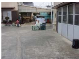
掘削前 設備土
