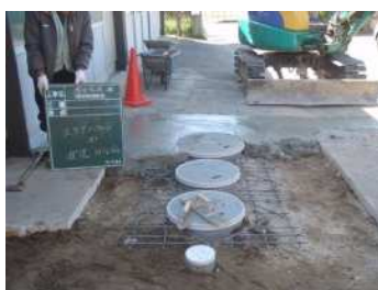
スラブ（コンクリート打ち）
