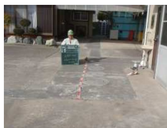
スラブ（完了） 設備土
