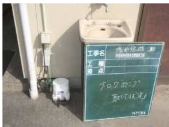
ブローア設置状況
