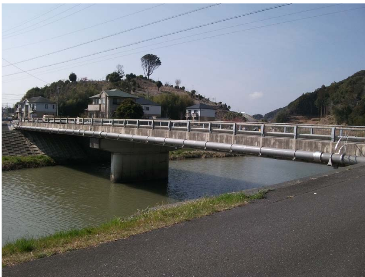
新川橋橋梁添架管 (SUS φ 400mm) : 平成 28 年度竣工
