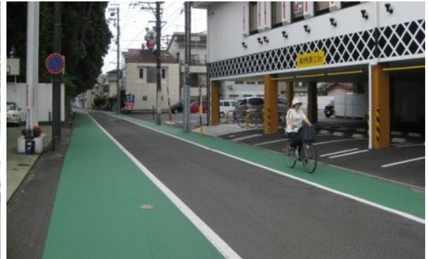
図 IV-8 路側帯の設置とカラー舗装の例
