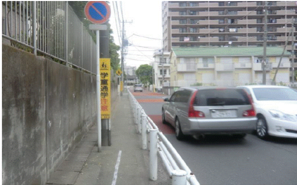
図 IV-7 防護柵の設置例
