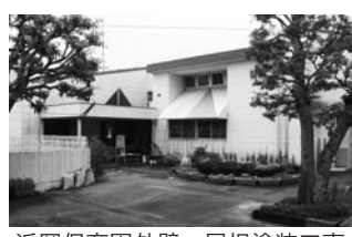
浜岡保育園外壁・屋根塗装工事
