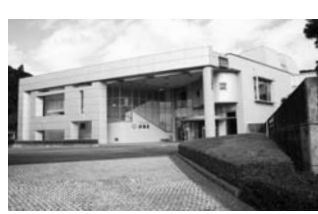
ぶるの屋根・外壁補修
