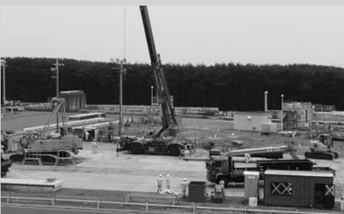
大型クレーン搬入
