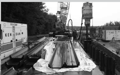
鋼矢板の打ち込み作業
