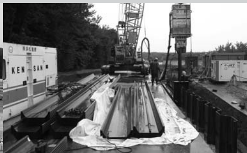
鋼矢板の打ち込み作業
