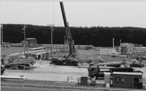
大型クレーン搬入
