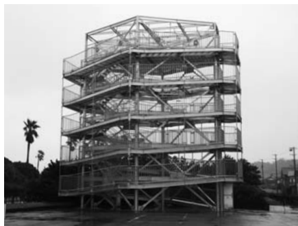
完成した津波避難タワー
