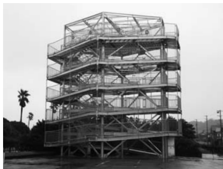
完成した津波避難タワー
