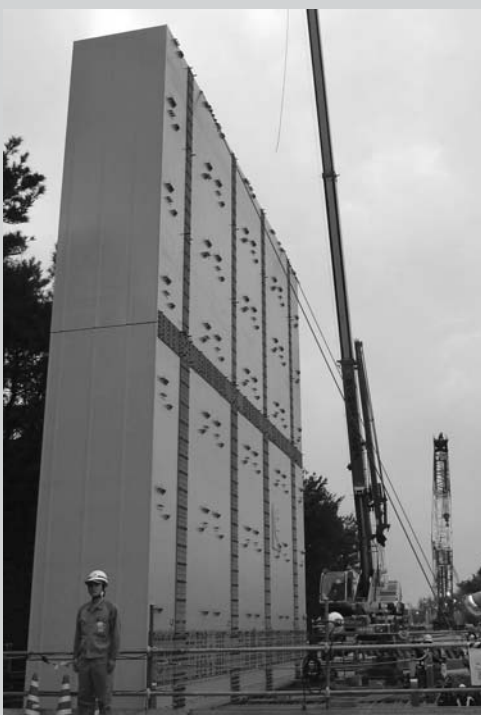
▲たて壁の設置状況 (4月25日撮影)
