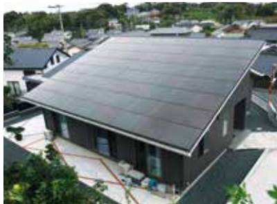
▲太陽光発電システム
