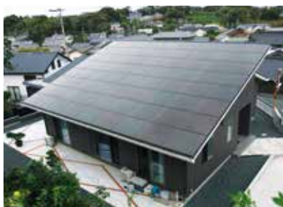
▲太陽光発電システム
