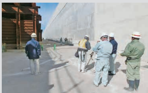
▲県と市が工事現場を確認してる様子
