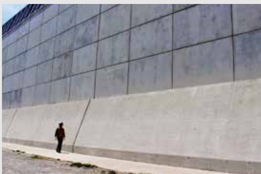
▲防波壁の設置(海拔22m)
