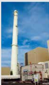
▲解体撤去する排気筒
