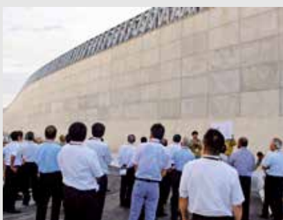
▲海抜22メートルの防波壁を見学
