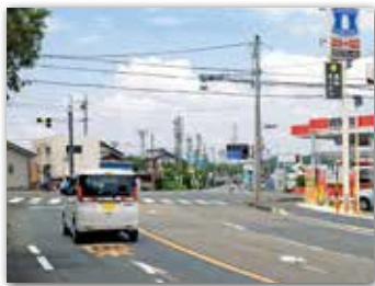
▼県道掛川浜岡線 苗代橋南交差点付近
