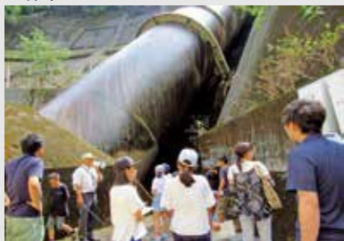
▼川口水力発電所を見学し説明を受ける様子
