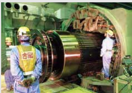
▲発電機解体工事の様子
