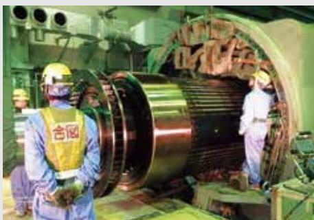
▲発電機解体工事の様子
