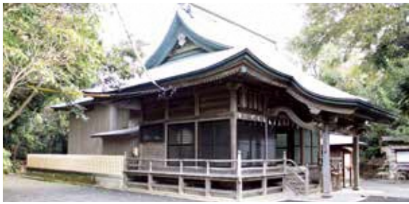
駒形拝殿（前側）と本殿（後側）の外観
