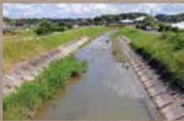
平成 16 年 10 月 9 日 新野川 普段の水位は 50% 程度の静かな河川が、 台風 22 号の豪雨により氾濫寸前になった
