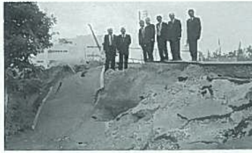
市内道路被災地
