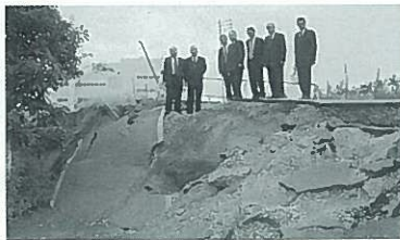
市内道路被災地
