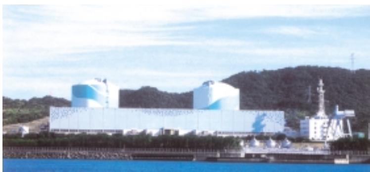
川内原子力発電所
