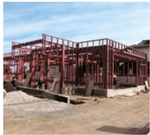
つばきの家(建設中)
