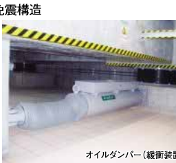
地下の免震構造
