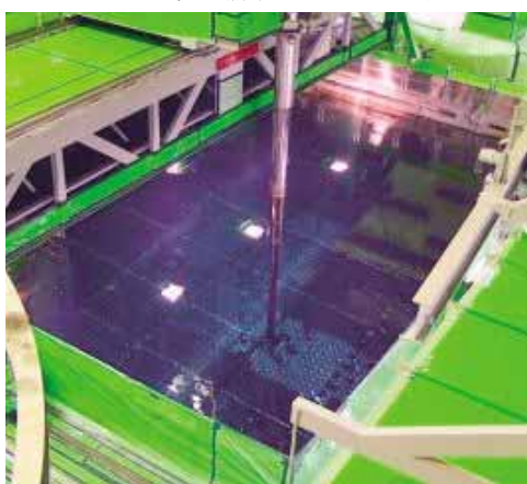
使用済燃料プール（中部電力株式会社より提供）
