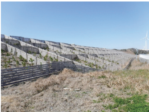
整備された防潮堤
