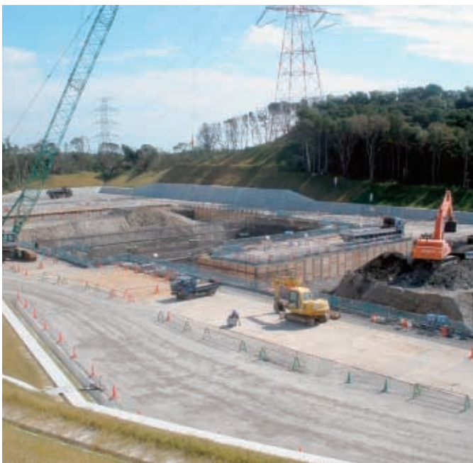
ガスタービン発電機設置工事（中部電力㈱より提供）
