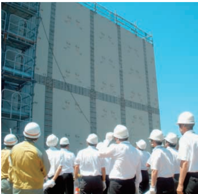
防波壁設置工事（中部電力㈱より提供）
