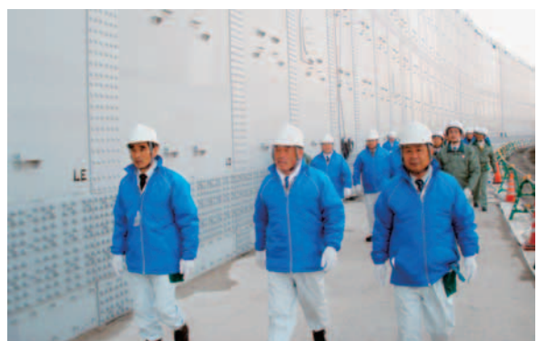
防波壁設置工事(中部電力様より提供)
