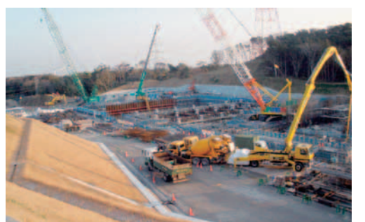
ガスタービン発電機設置工事(中部電力様より提供)
