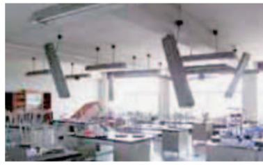
「照明器具（特別教室）の脱落」「学校施設の被構造部材の耐震化ガイドブック」（平成22年3月文部科学省発行）より抜粋
