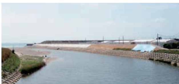
篠川嵩上げ工事
