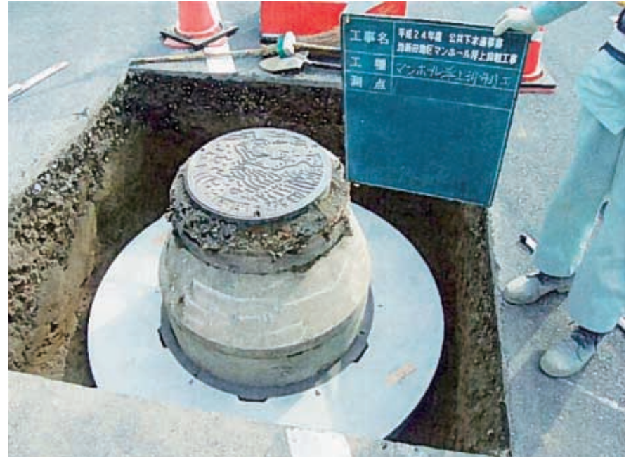
マンホール浮上抑制工事
