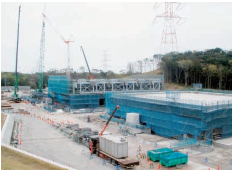
ガスタービン発電機設置工事(中部電力㈱より提供)
