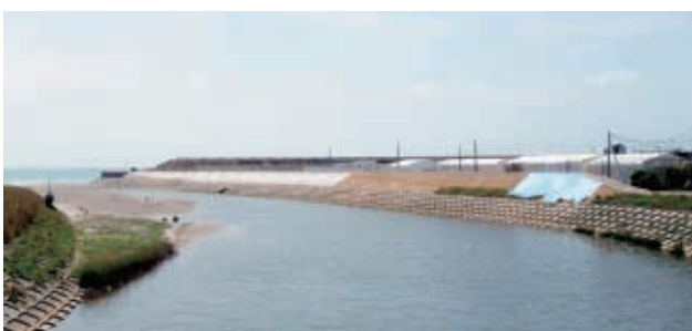
篠川嵩上げ工事
