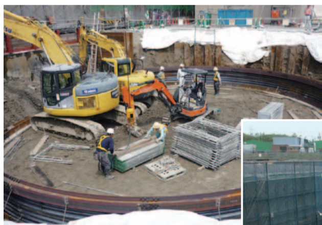
フィルタベント工事着手（中部電力株式会社より提供）
