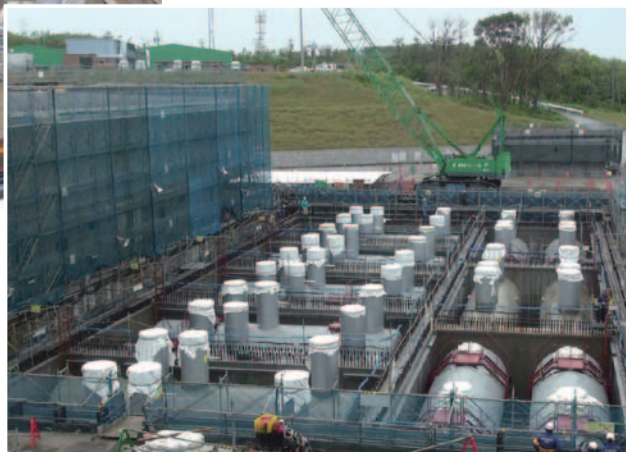
燃料タンク設置（中部電力株式会社より提供）
