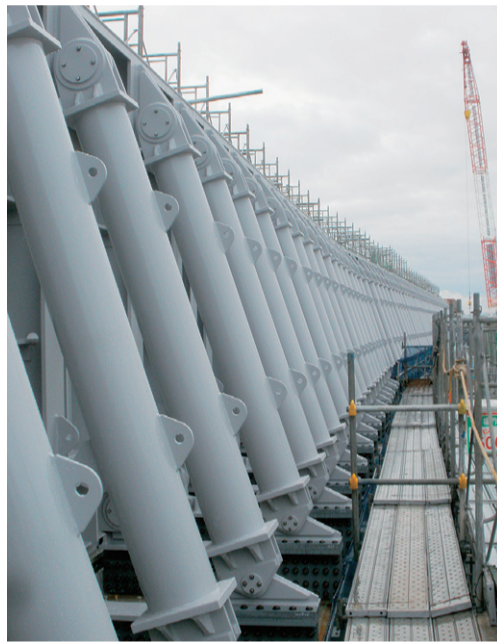
防波壁4m嵩上げ工事 (中部電力株式会社より提供)
