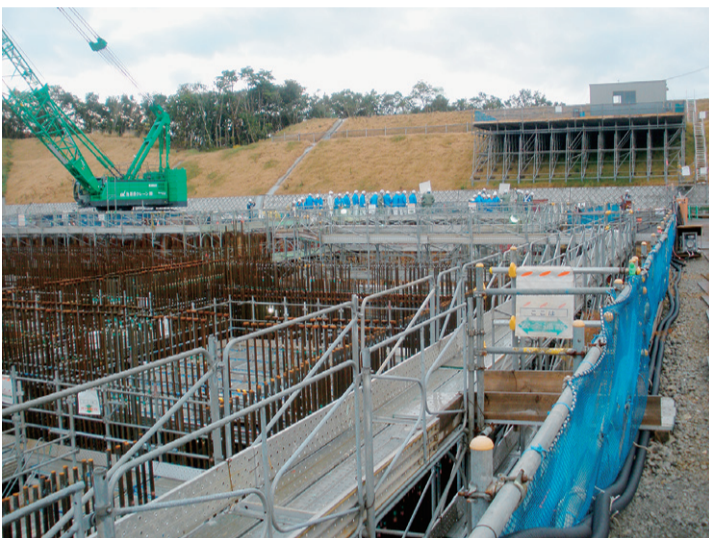
高台への地下水槽建設工事 (中部電力株式会社より提供)
