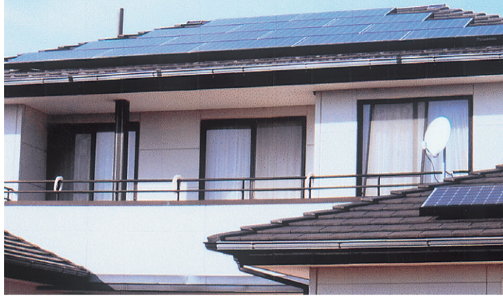
家庭用太陽光発電システム
