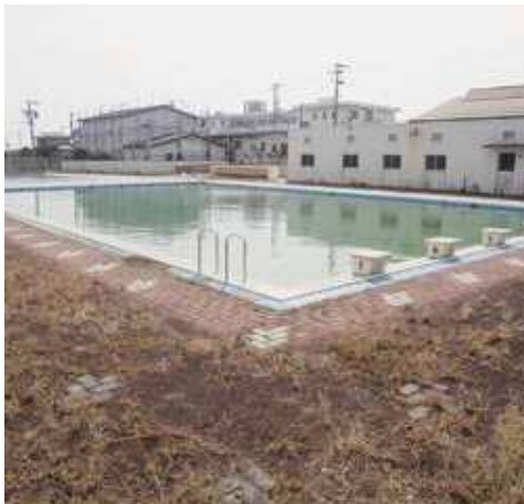
白羽小学校プール
