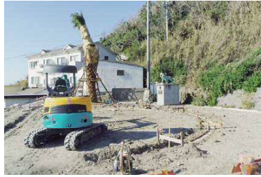
公園等造成工事
