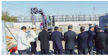
交流研修施設建築工事
