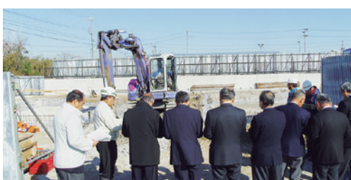
交流研修施設建築工事
