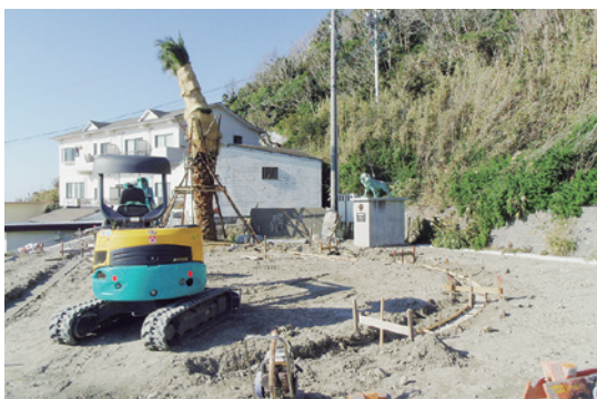
公園等造成工事
